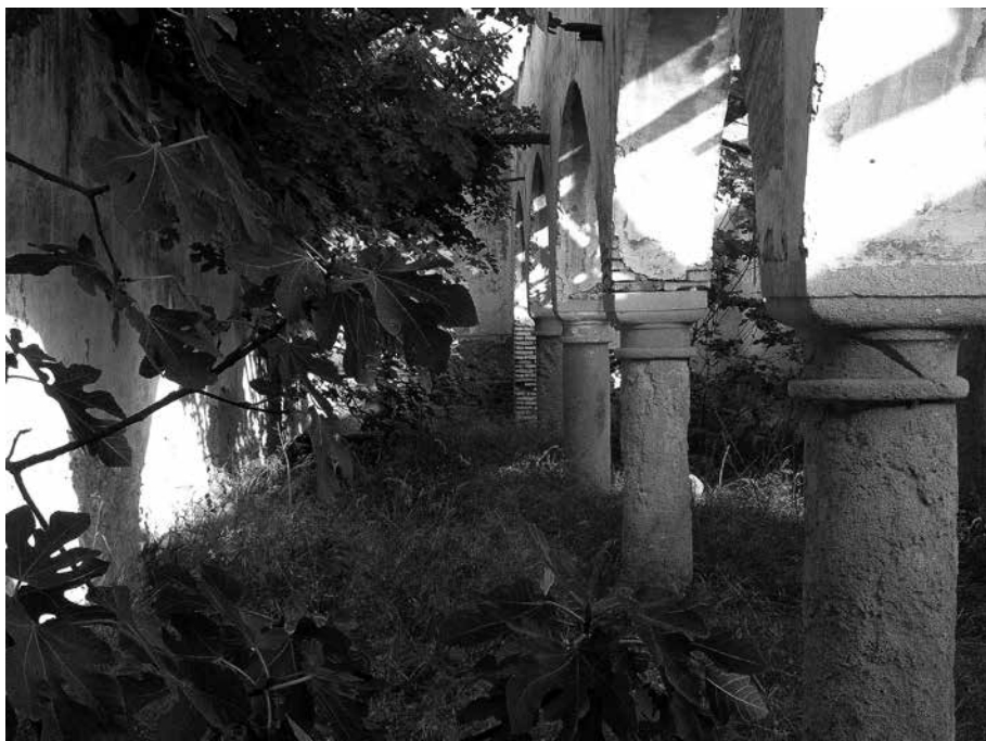
FIG. 4. Nave de bodega o tinahón con arquería central sobre columnas (2010). F. Bejines.
